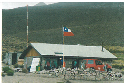
Schronisko nad Chungarą.
