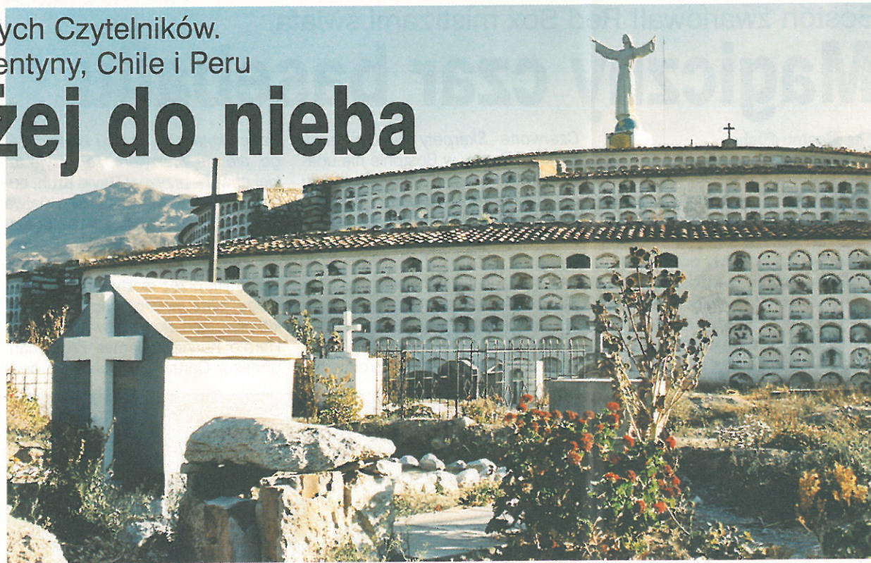
Budowle mają często nawet 10 kondygnacji i są długie na setki metrów
